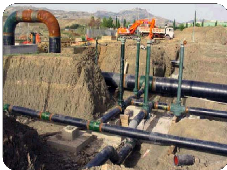
Lavori realizzati dalla Conas
