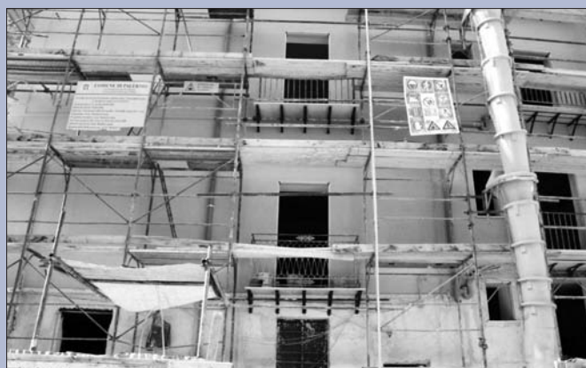
Un edificio in costruzione
