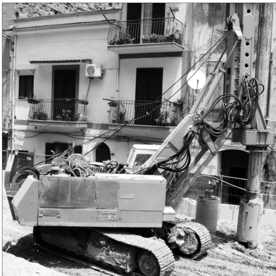
I lavori per il collettore fognario di Palermo
